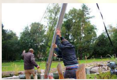
Aufstellung von Stützmasten
