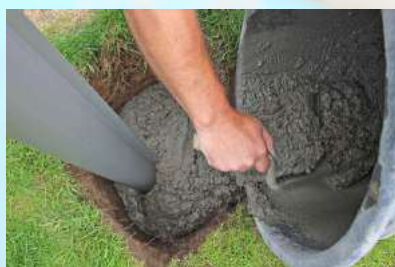
Verfüllung mit Beton
